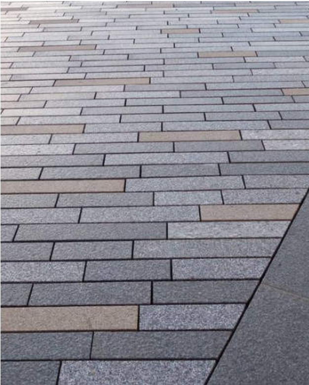
TRŽNICE ŽULOVÁ DLAŽBA
