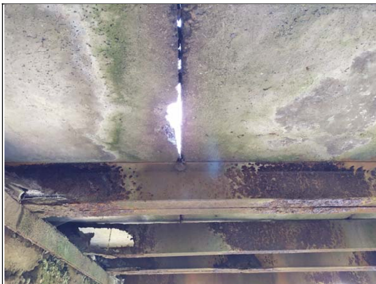
Chybějící materiál stojiny středního nosníku u opěry 1
