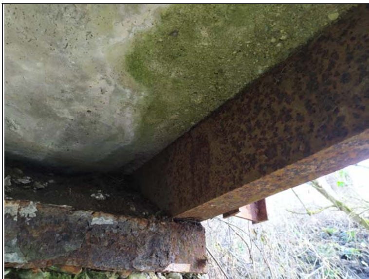
Uložení levého nosníku na opěru 1
