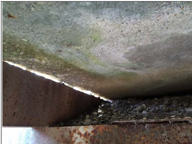
Uložení levého nosníku na opěru 2
