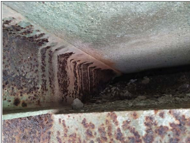
Uložení pravé dvojce nosníků na opěru 2
