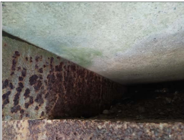
Uložení středního nosníku na opěru 2
