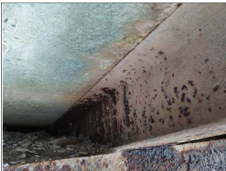
Uložení levé dvojce nosníků na opěru 2
