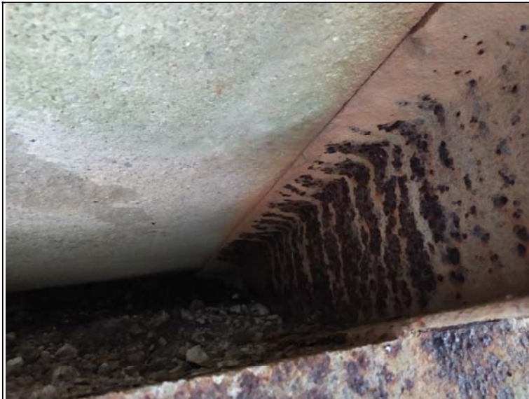
Uložení středního nosníku na opěru 2
