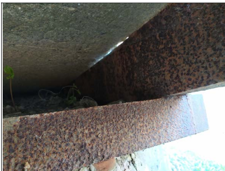
Uložení pravého nosníku na opěru 2
