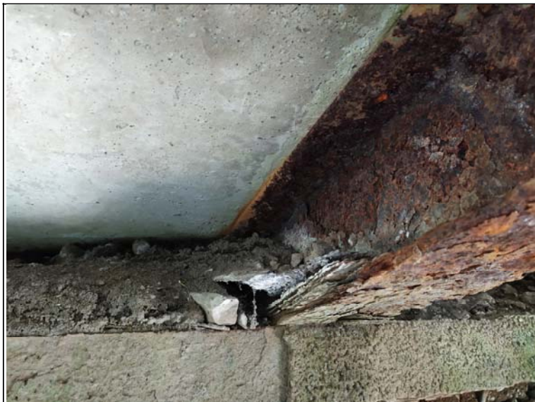
Uložení pravé dvojce nosníků na opěru 1
