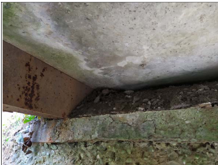
Uložení pravého nosníku na opěru 1
