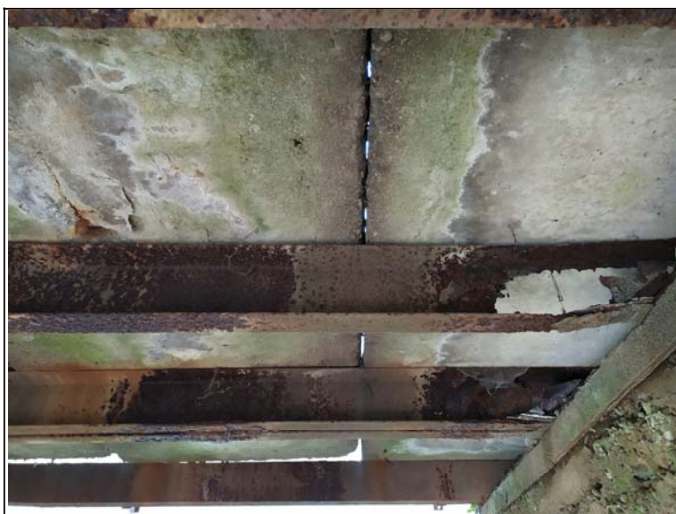
Chybějící materiál stojiny středního nosníku u opěry 1
