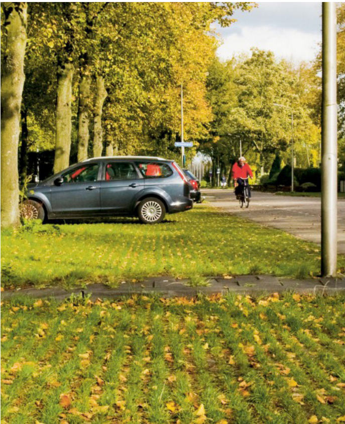
↑ materiálový koncept parkingu - zasakování niveleta komunikace stejná jako výška veřejného prostoru ↓ ref. parkování - zatravněná, skládaná dlažba
