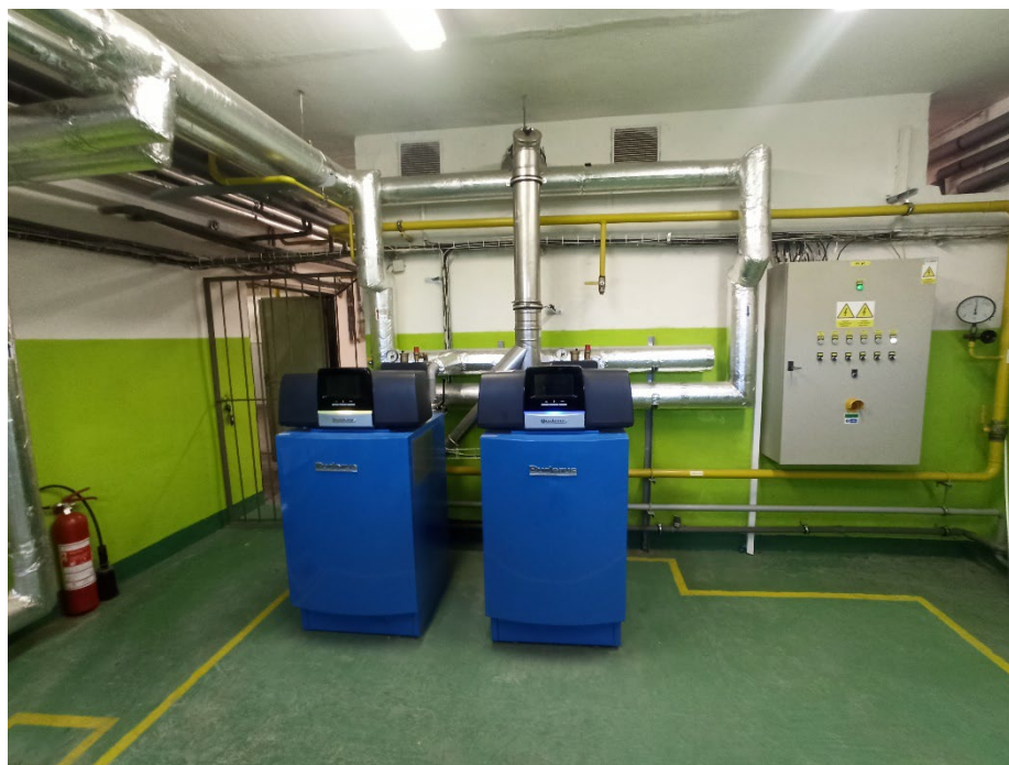
Obrázek 2-Stávající plynové kotle
