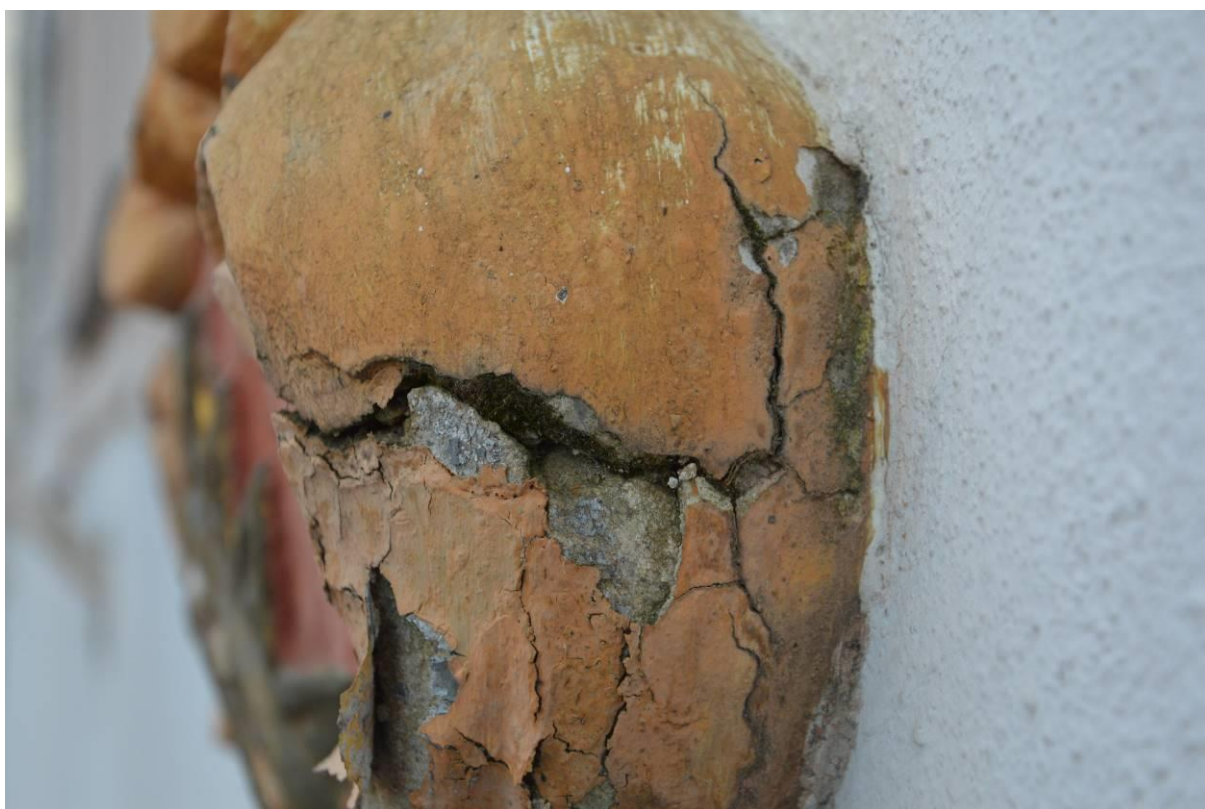
Detail díla z boku – pravá strana - poškození
