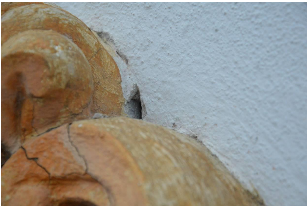
Detail díla – zapouštění do fasády
