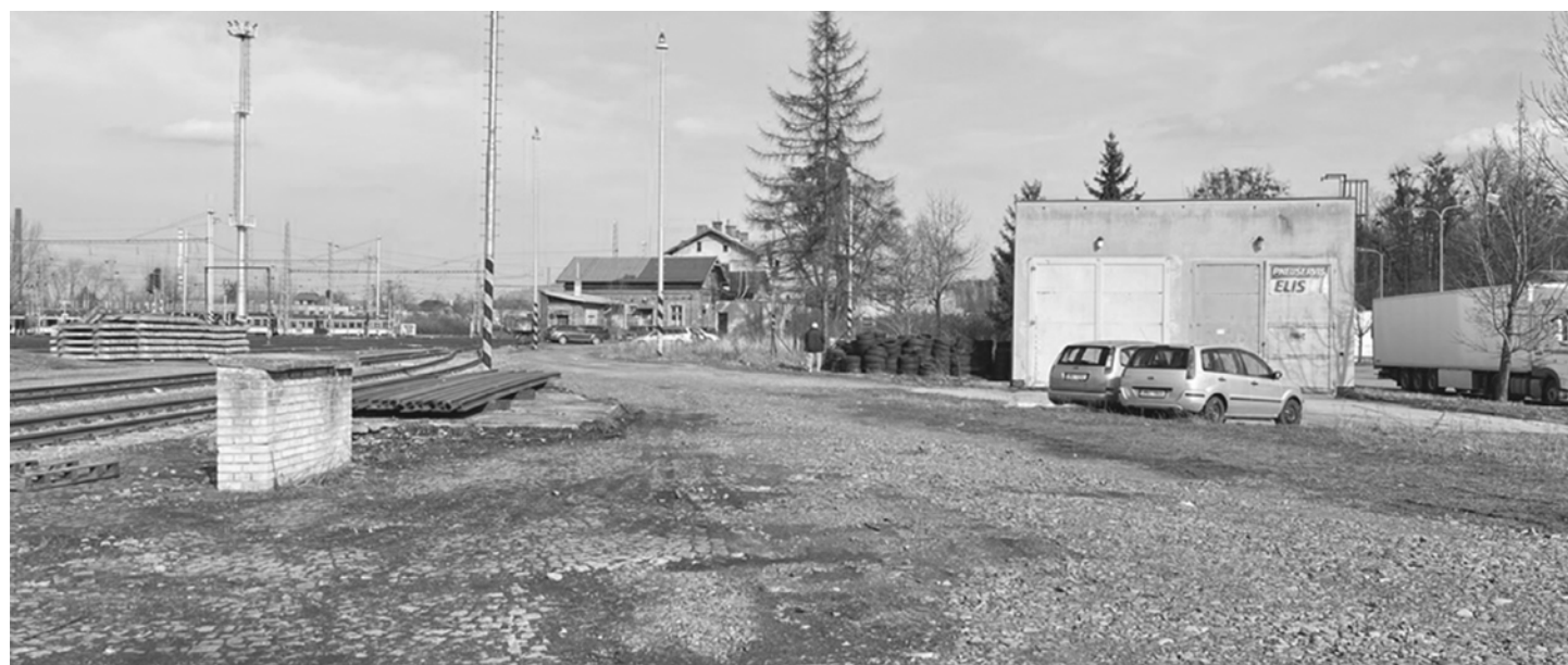
2/ stávající garáže a blízkost území ke kolejím
