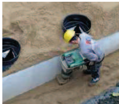
Obrázek č. 19: Hutnění bočního zásypu
