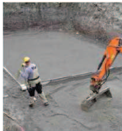
Obrázek č. 8: Příprava podkladu stavební jámy
