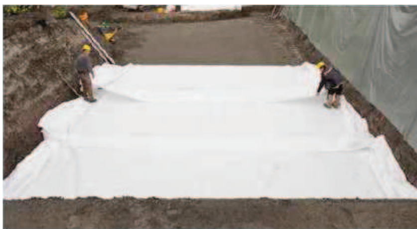
Obrázek č. 9: Pokládka geotextilie
